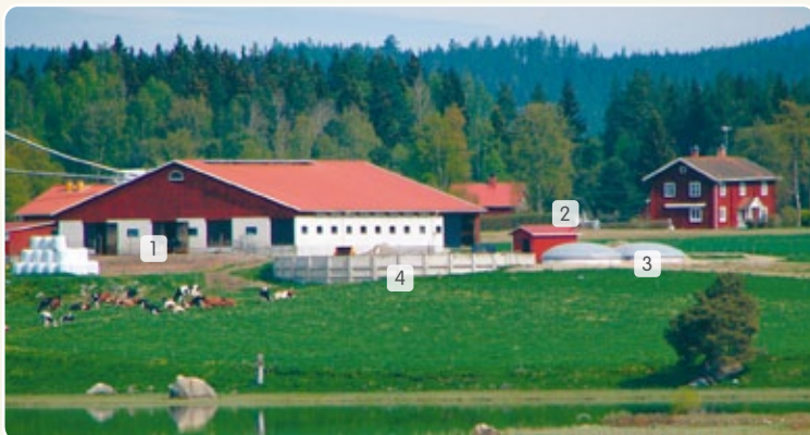
1) Gjødselkjeller 2) Pumpehus 3) Biowaz reaktorer 4) Sluttlager (vanlig gjødselkum)
