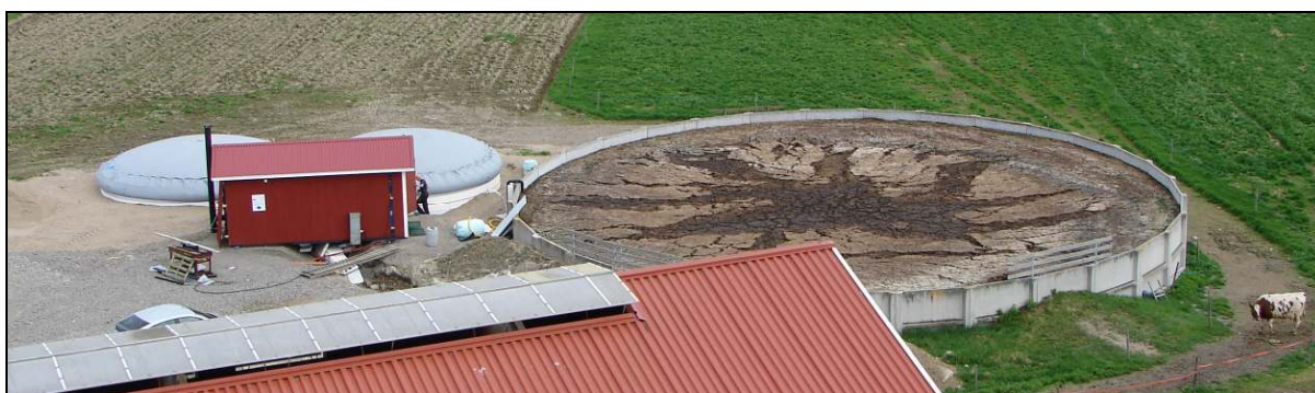
Fra venstre: BioWaz reaktorer med patentert vannlås-system, 20" teknikkcontainer med rød beklledning, eksisterende sluttlager.
