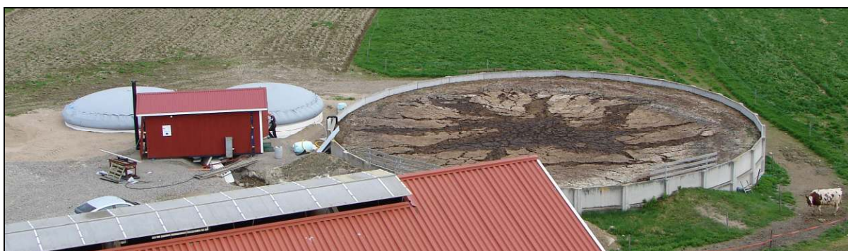
Fra venstre: BioWaz reaktorer med patentert vannlås-system, 20" teknikkcontainer med rød beklledning, eksisterende sluttlager.
