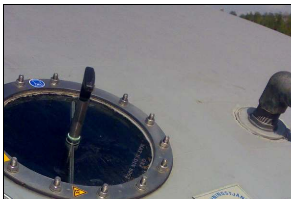
Venstre: 1 av de 3 reaktorene. Høyre: "Eye in the sky" (vindu for visuell observasjon i reaktoren), samt gassuttak.
